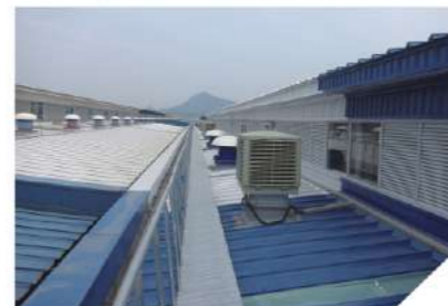
屋顶专用通道
